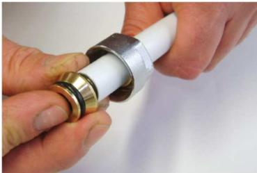
Introdurre fino a battuta il corpo del raccordo nella tubazione facendo attenzione a non danneggiare o scalzare i due anelli O-ring
