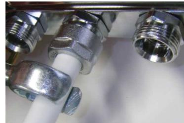
Avvitare manualmente la calotta all'attacco e serrarla a fondo mediante l'uso della chiave poligonale aperta per esagoni da 27 mm
