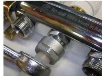
Avvitare manualmente la calotta all'attacco e serrarla a fondo mediante l'uso della chiave poligonale aperta per esagono da 27 mm
