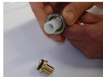
Die Überwurfmutter mit dem vormontierten Ring im Rohr stecken.
