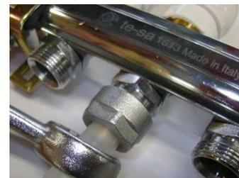
Mit der Hilfe von einem Schlüssel 27 mm. die Überwurfmutter bis zum Anschlag anschrauben.
